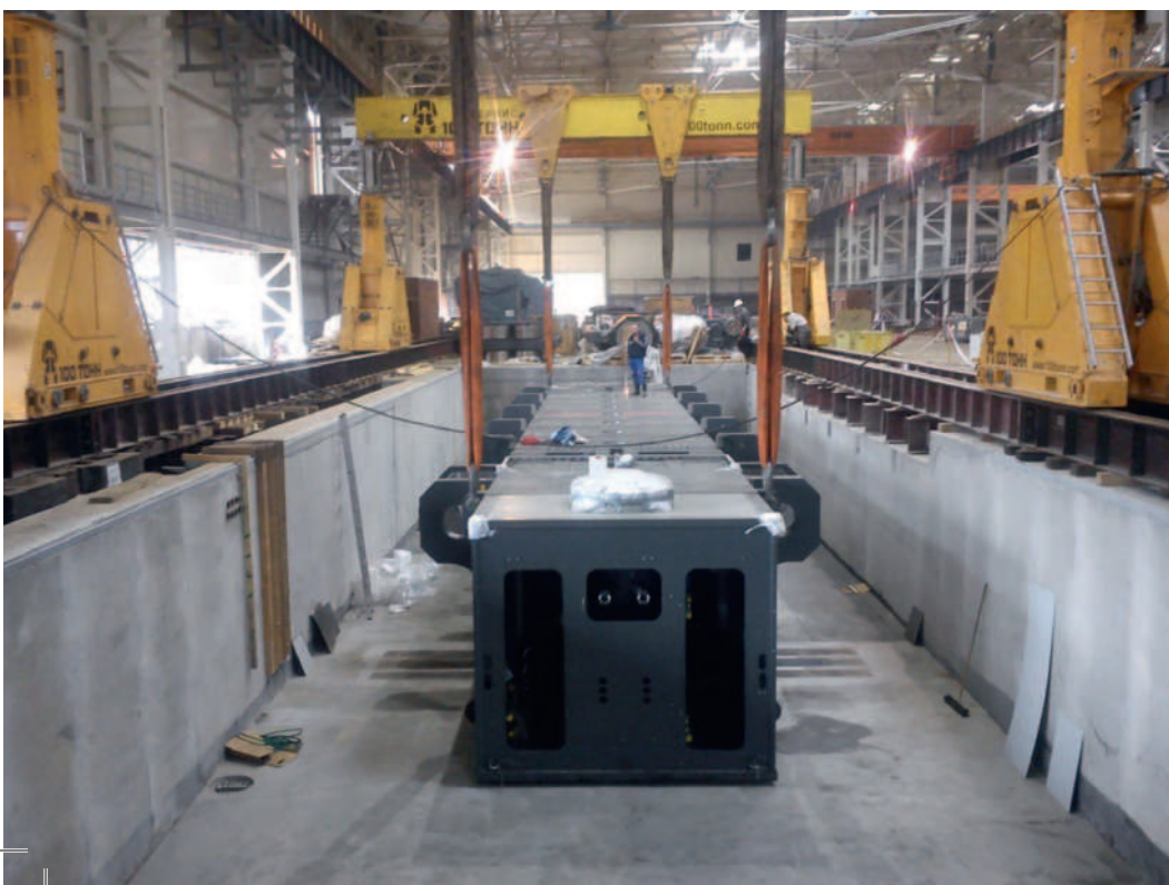
Момент монтажа валковой формовки
